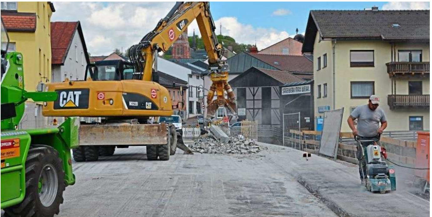
Die Gehwegkappen (Bürgersteige) auf der Amtmannbrücke sind in den letzten Tagen weitgehend entfernt worden. Künftig wird die Fahrbahn bis fast auf die Höhe der Gehwege angehoben. –Fotos: Schler
