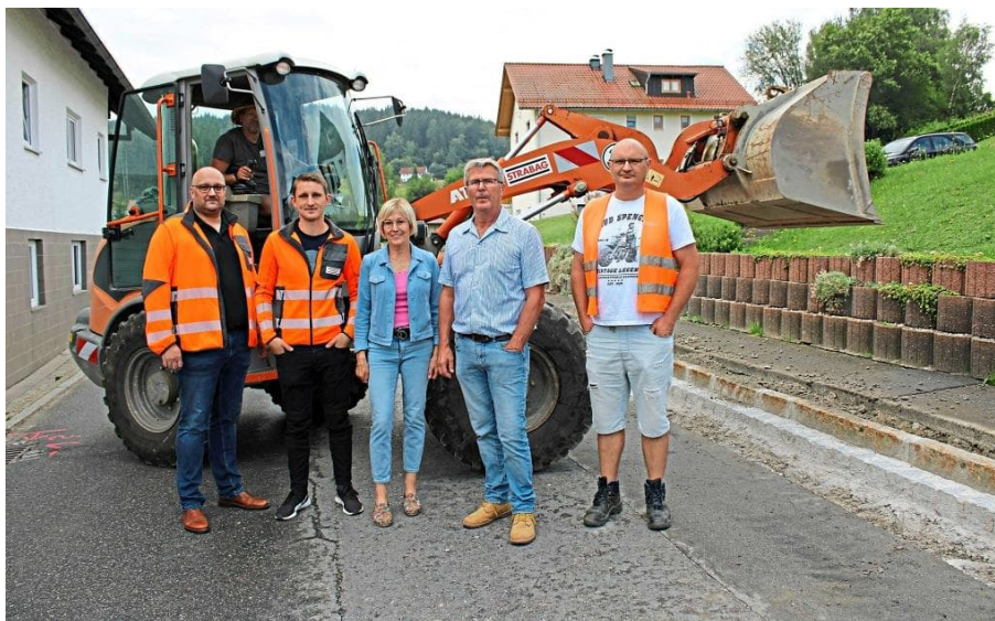
Bei der Baustellenbesichtigung: der technische Gruppenleiter Stefan Brunnbauer (von links), Bauleiter Christian Kraus (beide Firma Strabag), Bürgermeisterin Gaby Wittenzellner, Hans Moosbauer und Josef Wensauer (beide vom Planungsbüro „Kiendl & Moosbauer“). – Foto: Isolde Deiser
